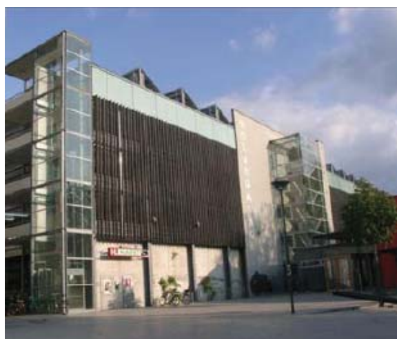
Parcheggio comune multipiano fotovoltaico
