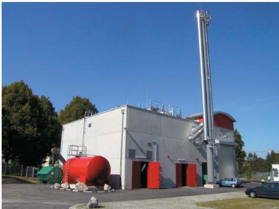
Impianto di co-generazione a cippato di legno che fornisce calore ed elettricità al quartiere
