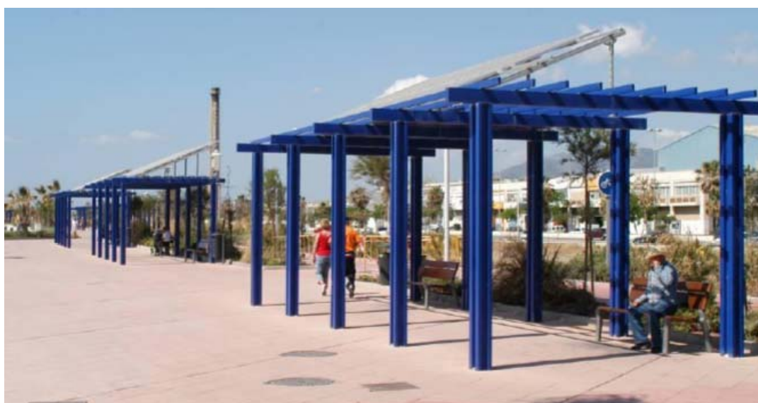
Tettoie con celle fotovoltaiche
