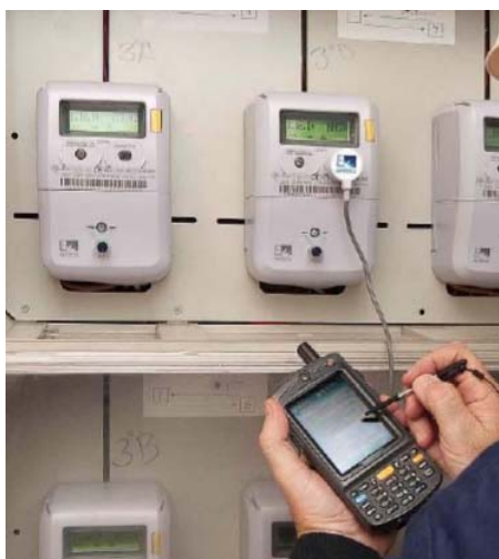
Contatori intelligenti e Concentratori di Telegestione
