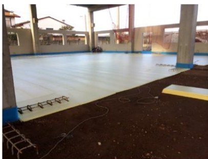
Posa isolante per impianto di riscaldamento
